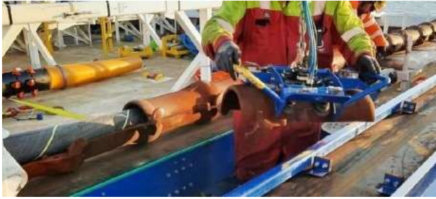
Mise en place des coquilles en fonte sur le câble avant mise à l'eau. (Photo : LDA-TVO)
