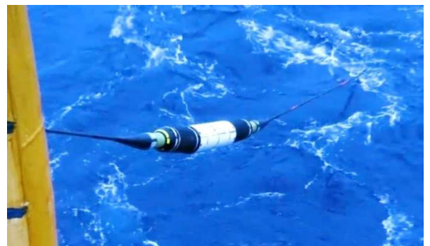
À gauche, stockage de répéteurs dans l'espace dédié du hangar d'un câblier ASN. À droite, déploiement d'un répéteur lors de la pose d'un câble.
