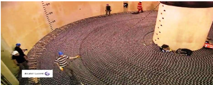
Chargement d'un câble avec armure dans une des cuves du câblé Île de Batz. On arrive à 3 m de hauteur.
